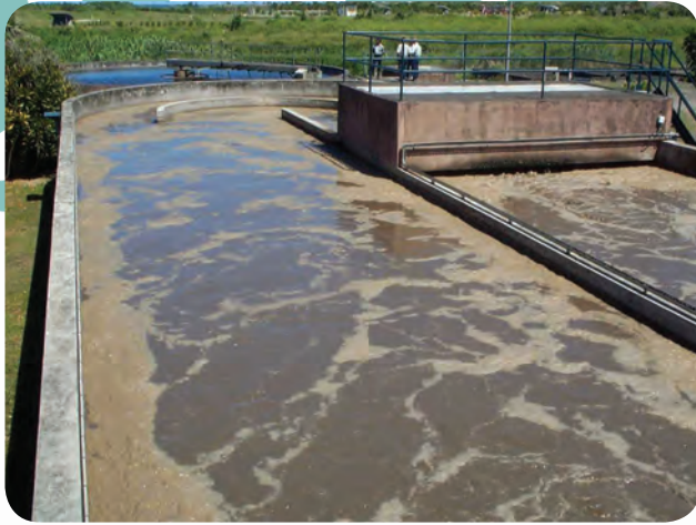
Couverture en béton au-dessous d'un pont-brosse
